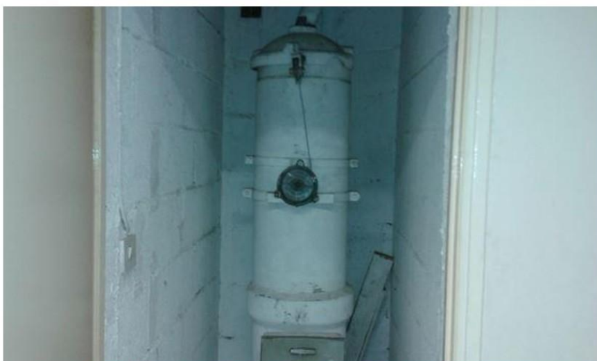
Local vides ordures (3ème étage) - Conduit de vide-ordures - Fibre ciment
