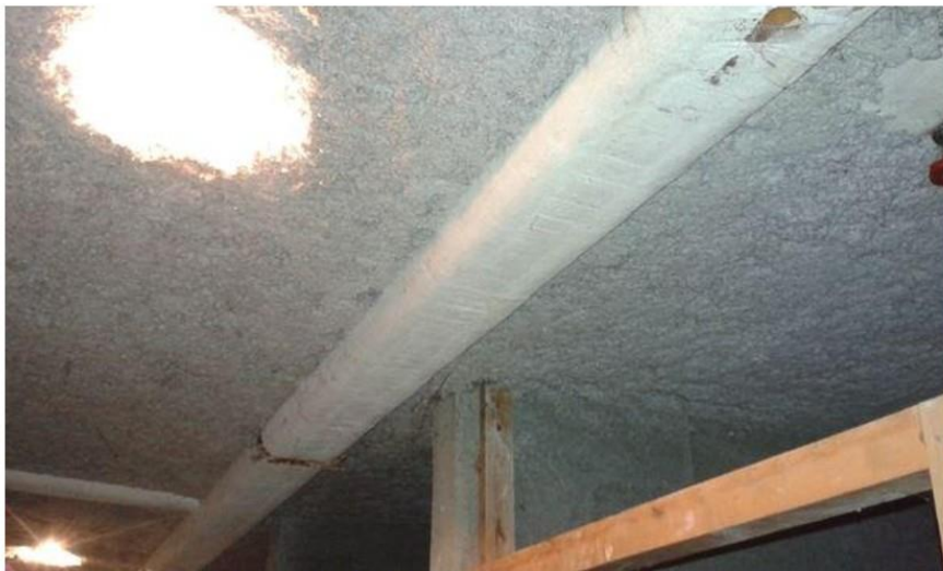
P2 - Caves (Rdc) - Canalisation calorifugée - Canalisation calorifugée
