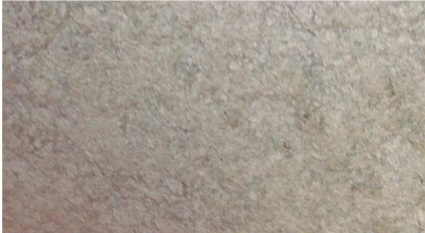
P1 - Caves (Rdc) - Plafond - Flocage
