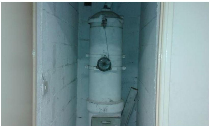
Local vides ordures (1er étage) - Conduit de vide-ordures - Fibre ciment
