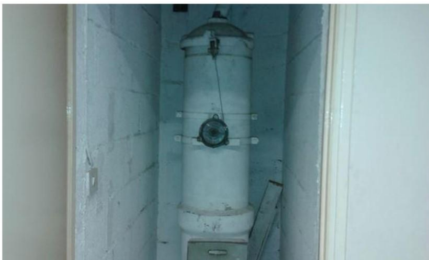
Local vides ordures (2ème étage) - Conduit de vide-ordures - Fibre ciment
