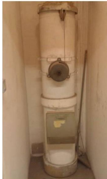
Local vidés ordures (3ème étage) - Conduit de vidés ordures - Fibre ciment
