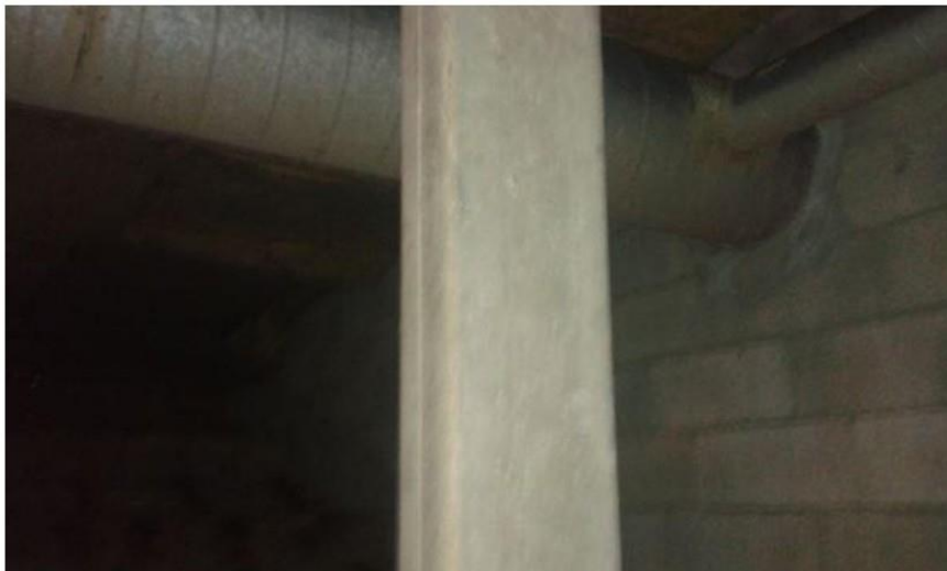
Comble (4ème étage) - Conduits de ventilation, aération - Fibre ciment
