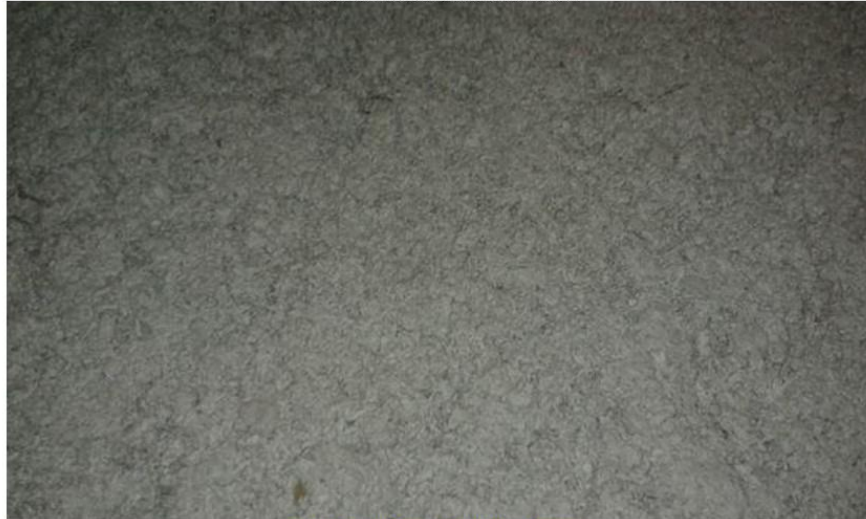
P1 - Caves (Rdc) - Plafond - Flocage
