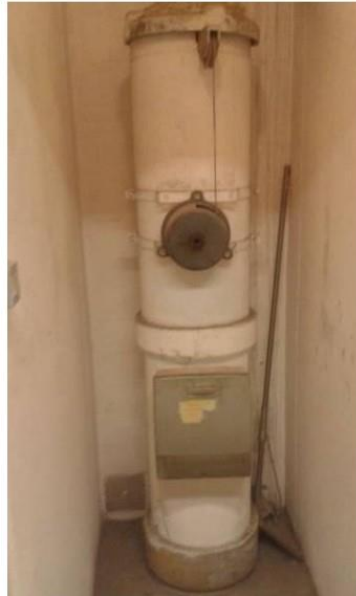
Local vidés ordures (2ème étage) - Conduit de vidés ordures - Fibre ciment
