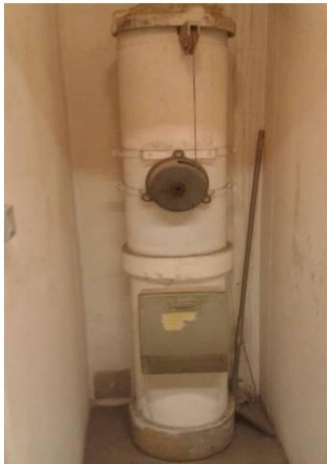
Local vides ordures (1er étage) - Conduit de vide-ordures - Fibre ciment
