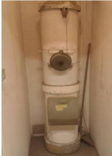
Local poubelles (Rdc) - Conduit de vide-ordures - Fibre ciment
