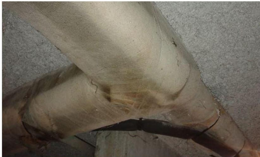
P2 - Caves (Rdc) - Canalisation calorifugée - Canalisation calorifugée
