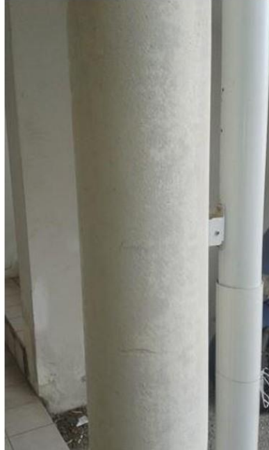
Dégagement (Rdc) - Poteau coffrage perdu - Fibre ciment
