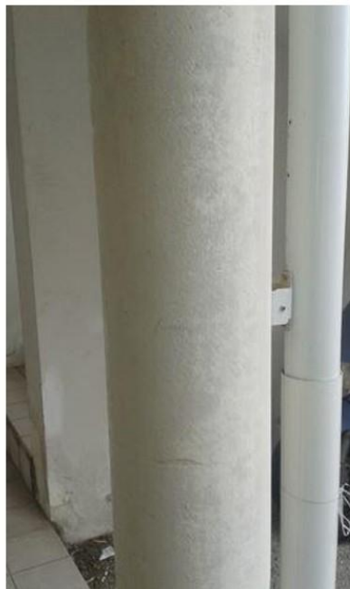
Dégagement (2ème étage) - Poteau coffrage perdu - Fibre ciment
