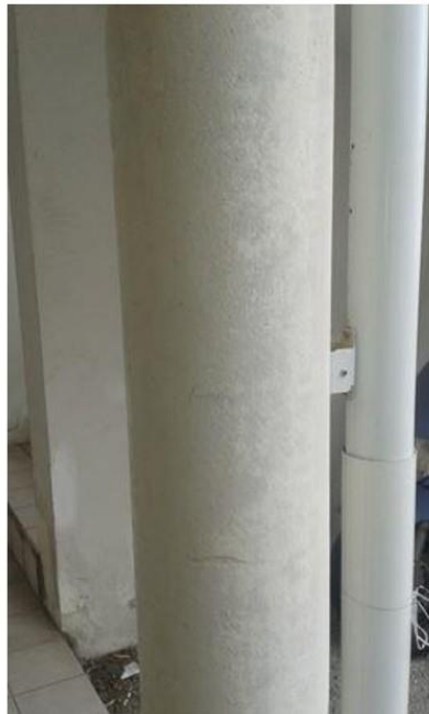
Dégagement (3ème étage) - Poteau coffrage perdu - Fibre ciment
