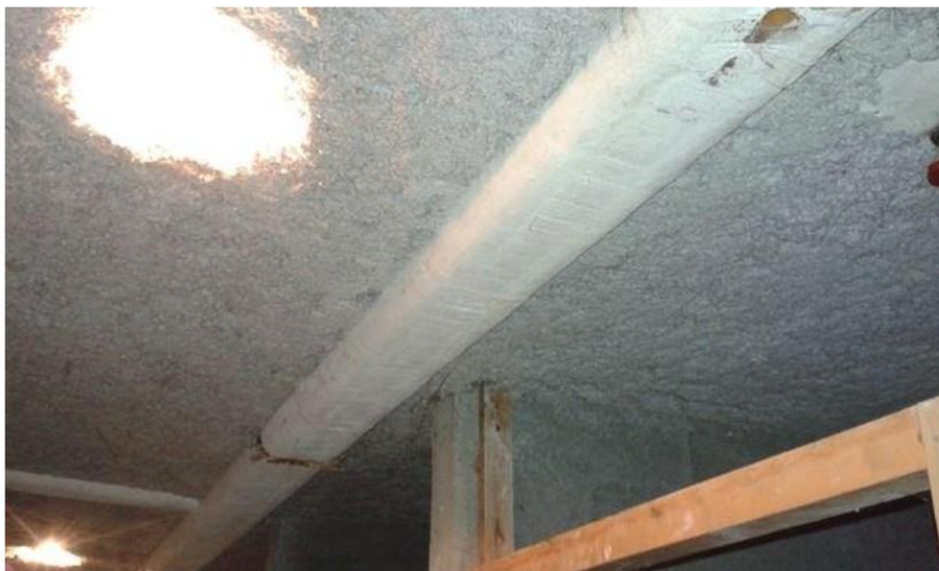
P2 - Caves (Rdc) - Canalisation calorifugée - Canalisation calorifugée
