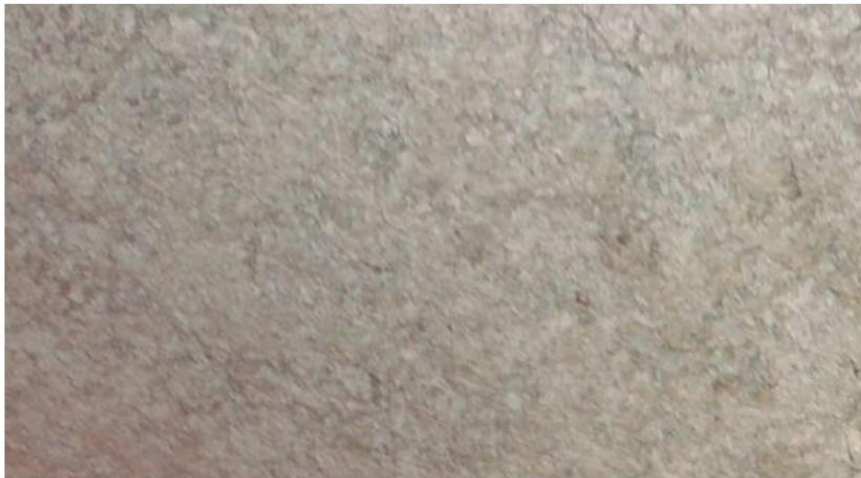
P1 - Caves (Rdc) - Plafond - Flocage
