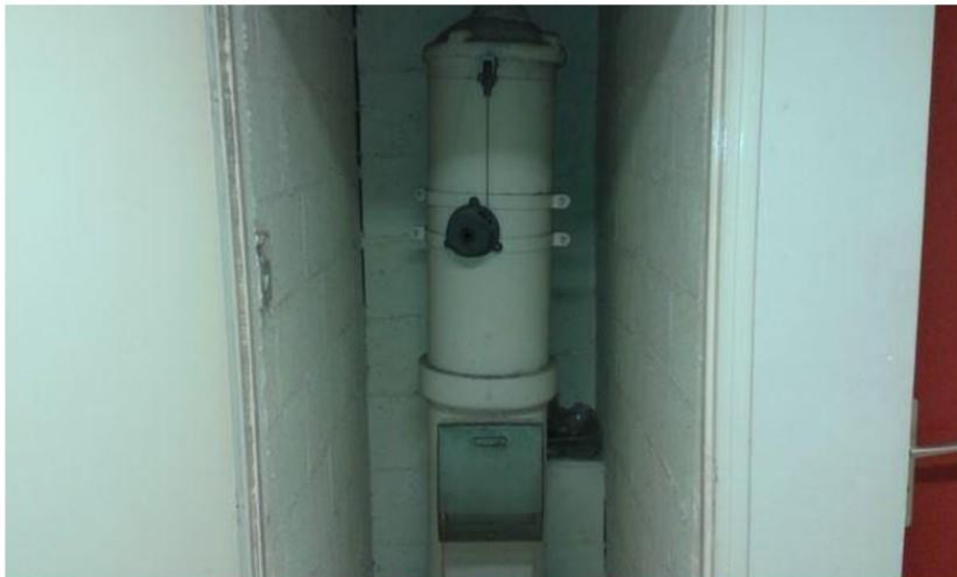
Local vides ordures (3ème étage) - Conduit de vides-ordures - Fibre ciment
