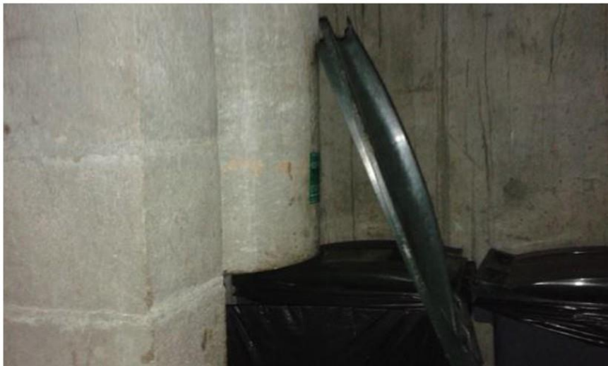
Local poubelles (Rdc) - Conduit de vide-ordures - Fibre ciment
