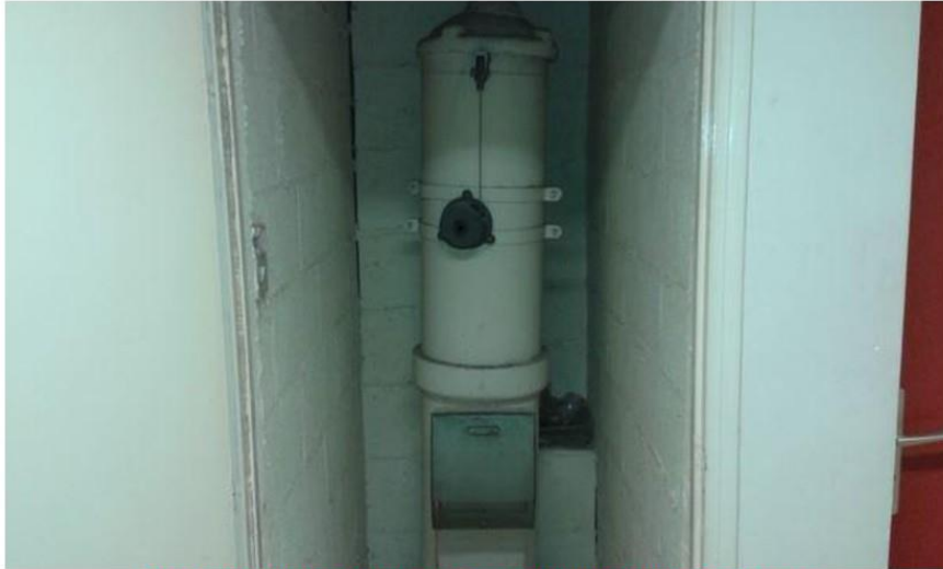
Local vides ordures (2ème étage) - Conduit de vides-ordures - Fibre ciment
