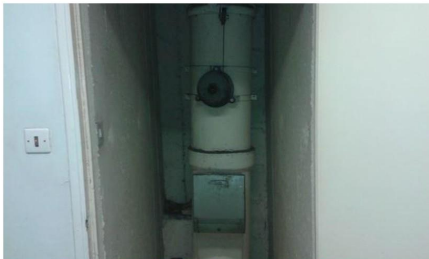
Local vidés ordures (3ème étage) - Conduit de vidés-ordures - Fibre ciment
