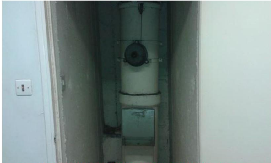
Local vidés ordures (2ème étage) - Conduit de vidés-ordures - Fibre ciment
