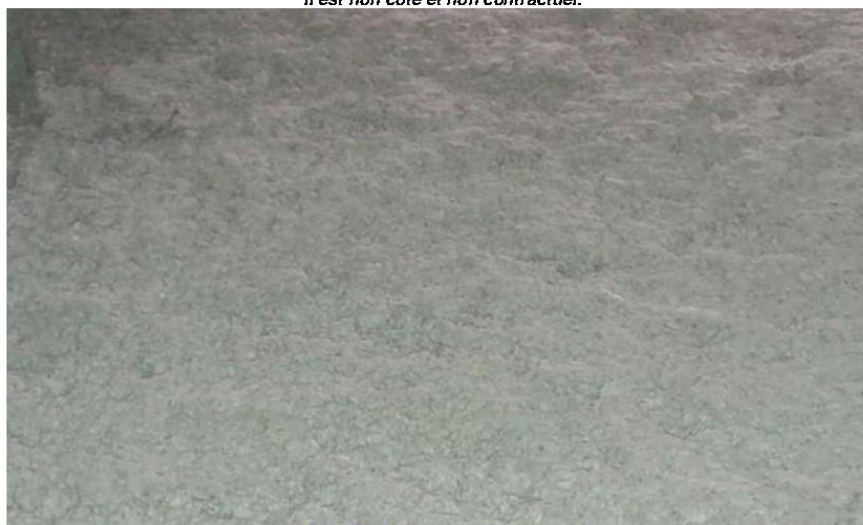
P1 - Caves (Rdc) - Plafond - Flocage
