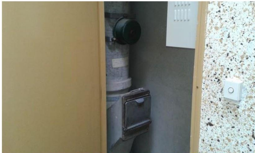
Gaines techniques (3ème étage) - Canalisation calorifugée - Canalisation calorifugée
