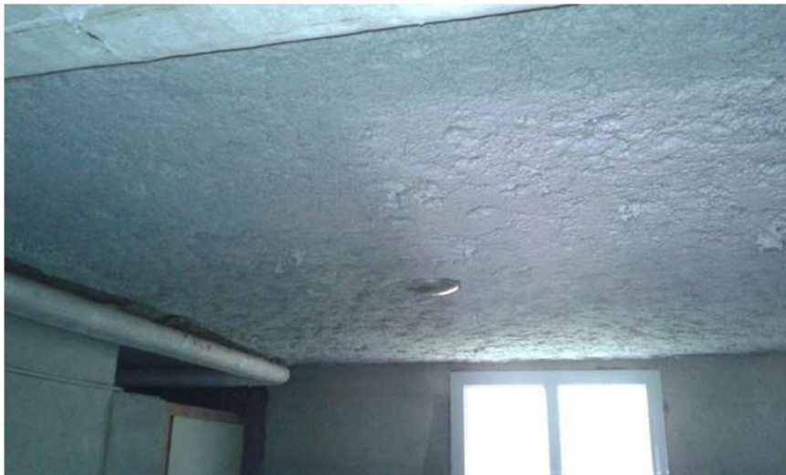
P1 - Local Vélo (Rdc) - Plafond - Flocage
