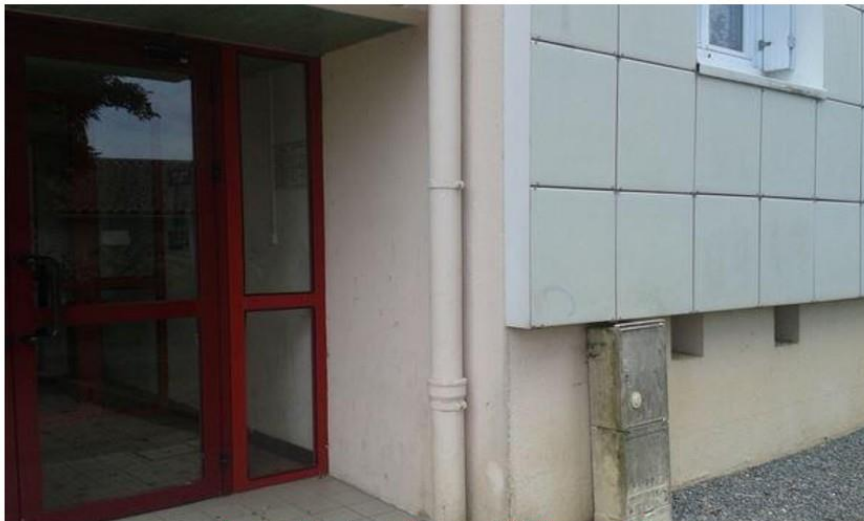
Façades (Extérieurs) - Descentes EP - Descentes EP
