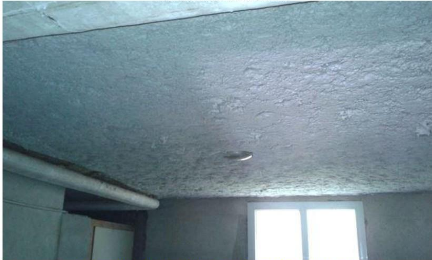
P2 - Local Poubelle (Rdc) - Plafond - Calorifugeage plâtre + laine minérale
