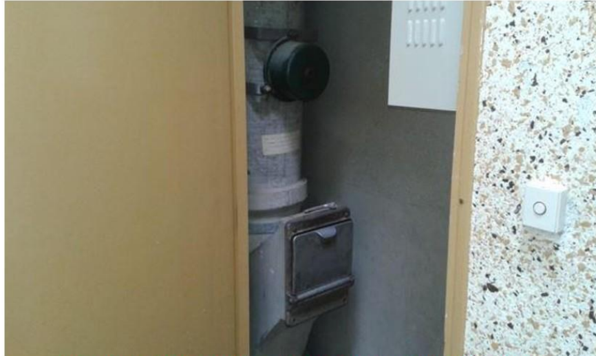
Gaines techniques (2ème étage) - Canalisation calorifugée - Canalisation calorifugée
