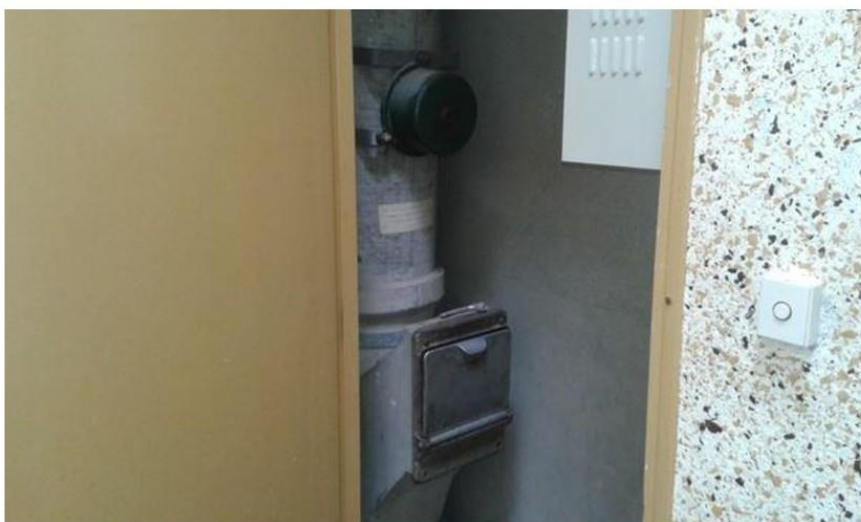
Gaines techniques (1er étage) - Canalisation calorifugée - Canalisation calorifugée
