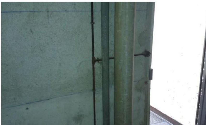
Combles (4ème étage) - Mur - Fibre ciment
