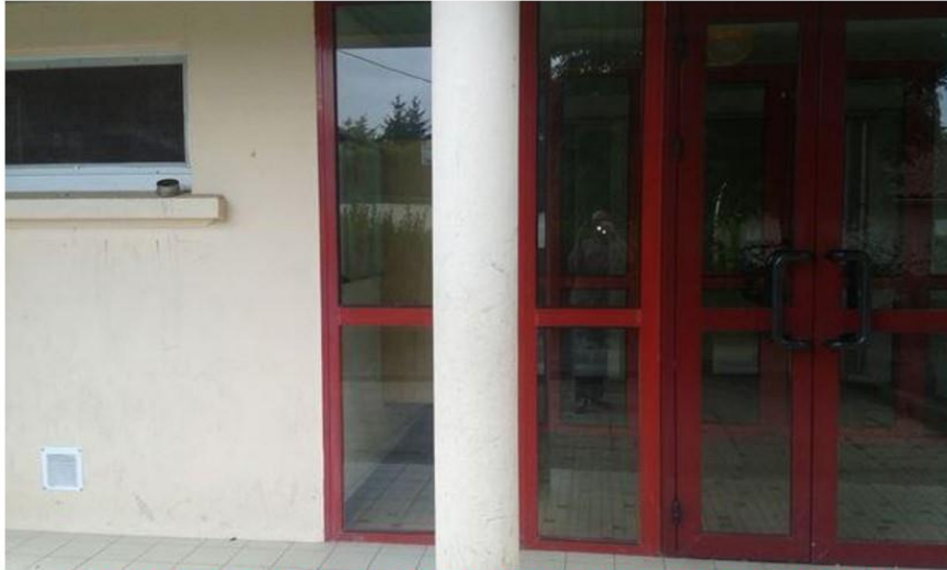
Façades (Extérieurs) – Poteaux coffrage perdu habillés fibre ciment contenant de l'amiante
