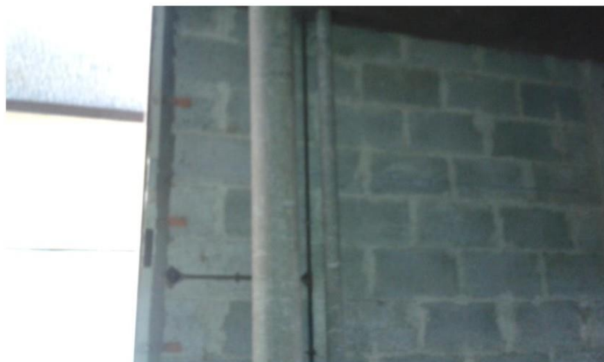
Combles (4ème étages) - Conduit - Fibre ciment
