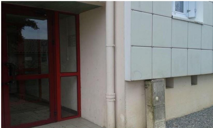
Façades (Extérieurs) - Descentes EP - Descentes EP
