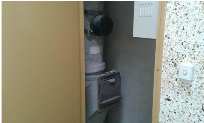
Gaines techniques (1er étage) - Conduit - Fibre ciment
