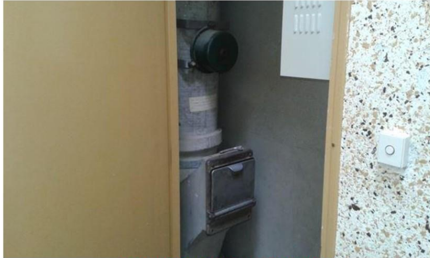
Gaines techniques (Rdc) - Conduit - Fibre ciment
