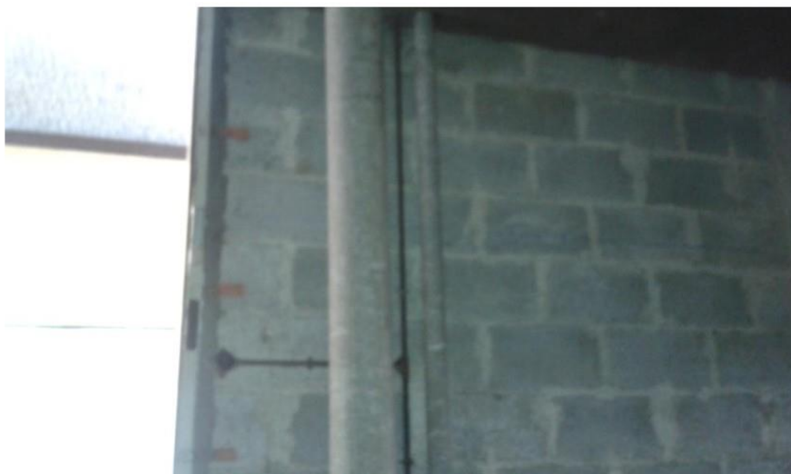
Combles (4ème étages) - Conduit - Fibre ciment
