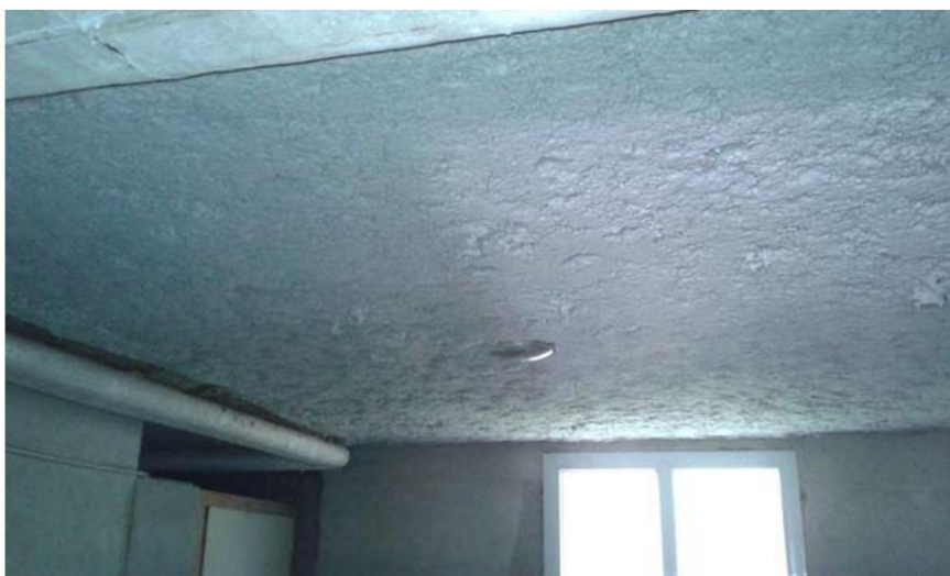
P2 - Local vélos (Rdc) - Plafond - Calorifugeage plâtre + laine minérale
