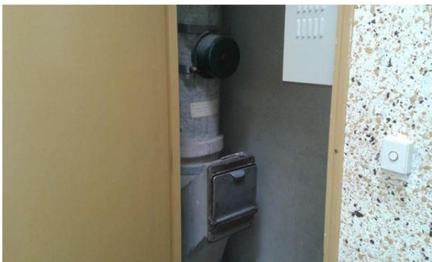
Gaines techniques (2ème étage) - Conduit - Fibre ciment
