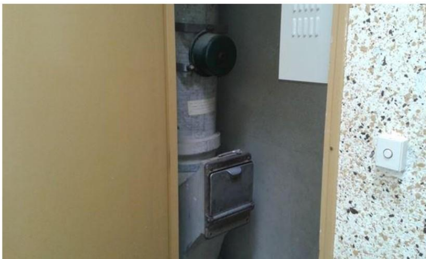
Gaines techniques (3ème étage) - Conduit - Fibre ciment
