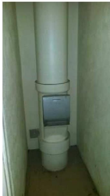
Local vide ordure (2ème étage) - Conduit de vide-ordures - Fibre ciment
