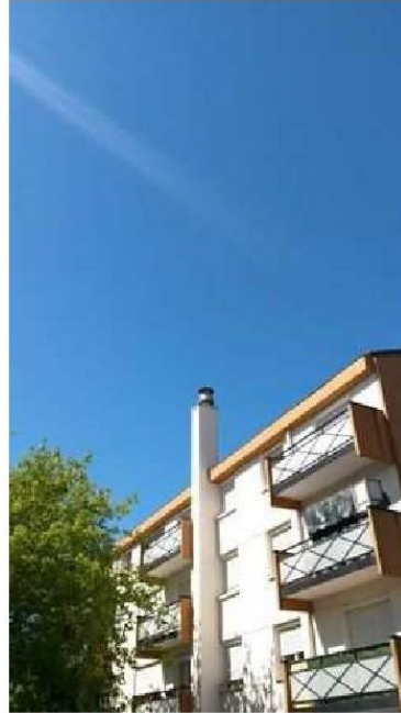
Toiture (Extérieur) - Conduit(s) de fumée - Fibre ciment
