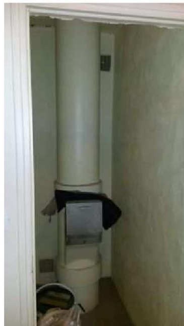
Local vide ordure (Rdc) - Conduit de vide-ordures - Fibre ciment
