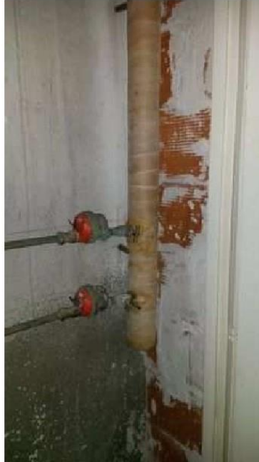
P2 - Placards techniques (Rdc) - Canalisation calorifugée - Canalisation calorifugée
