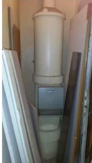
Local vide ordure (3ème étage) - Conduit de vide-ordures - Fibre ciment
