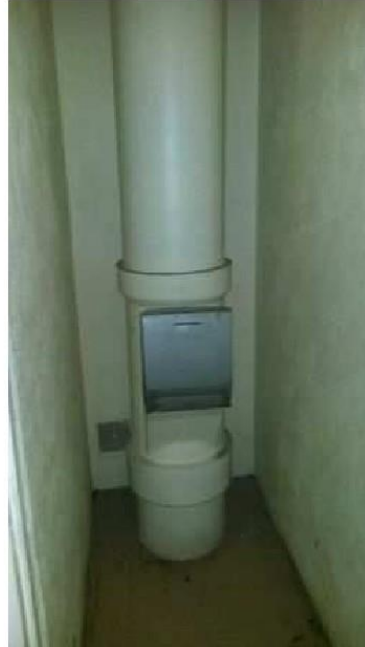
Local vide ordure (1er étage) - Conduit de vide-ordures - Fibre ciment
