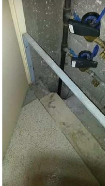
P3 - Placards techniques (3ème étage) - Sol - Dalles de sol (30x30, beige)
