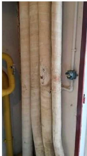
P1 - Chaufferie (Rdc) - Canalisation calorifugée - Canalisation calorifugée
