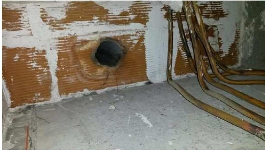
Placards techniques (3ème étage) - Conduits de ventilation, aération - Fibre ciment
