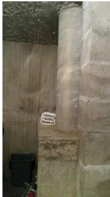
Local vide ordures (Rdc) - Conduit de vide-ordures - Fibre ciment
