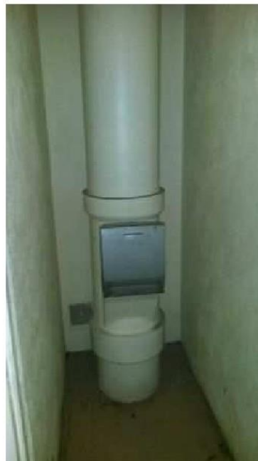
Local vide ordure (2ème étage) - Conduit de vide-ordures - Fibre ciment
