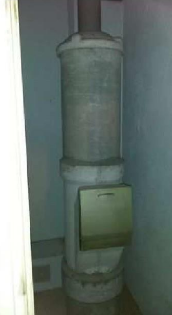
Local vide ordure (3éme étage) - Conduit de vide-ordures - Fibre ciment
