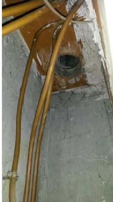
Placards techniques (3ème étage) - Conduits de ventilation, aération - Fibre ciment
