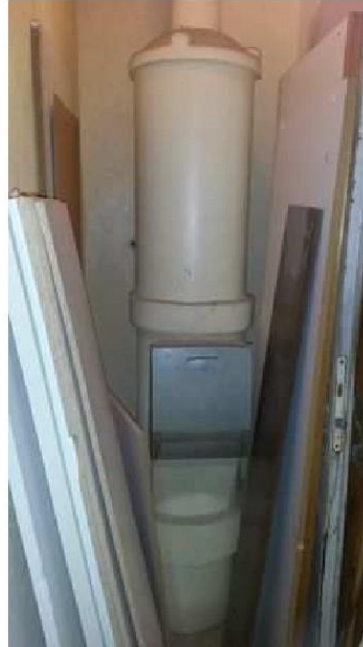
Local vide ordures (3ème étage) - Conduit de vide-ordures - Fibre ciment
