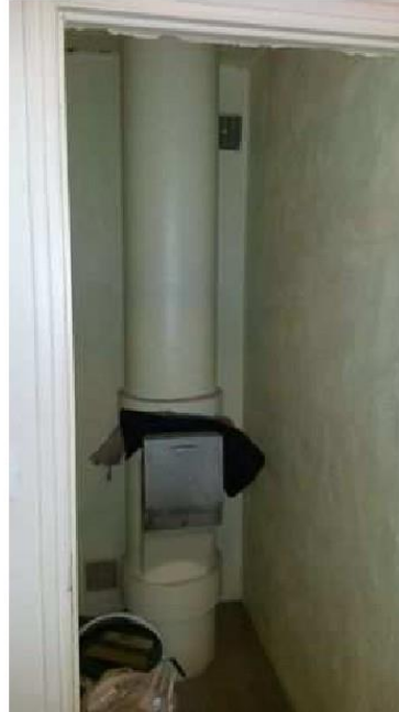
Local vide ordure (1er étage) - Conduit de vide-ordures - Fibre ciment
