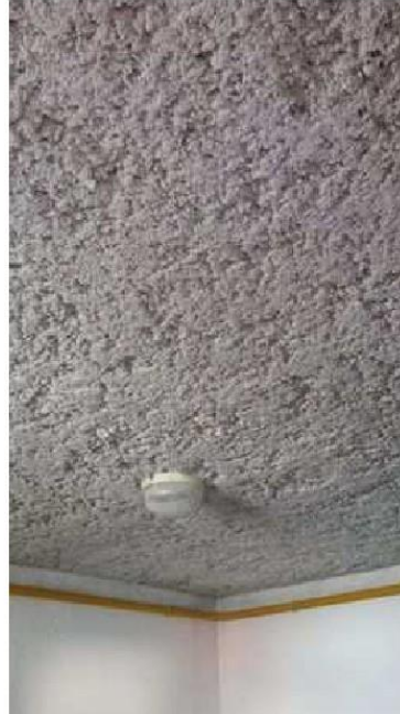
P2 - Local vélo (Rdc) - Plafond - Flocage
