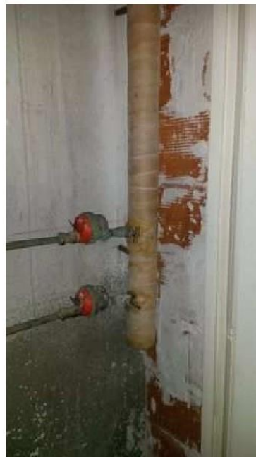
P1 - Placards techniques (Rdc) - Canalisation calorifugée - Canalisation calorifugée
