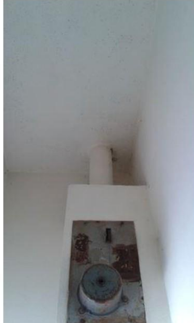
Local vide ordures (3ème étage - 3) - Conduit - Fibre ciment
