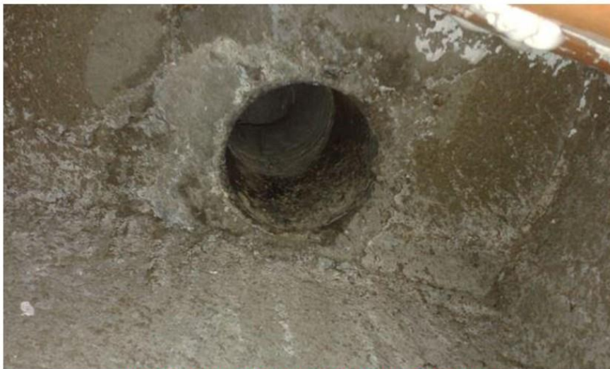
Gaines techniques 1 (3ème étage - 3) - Conduit - Fibre ciment
