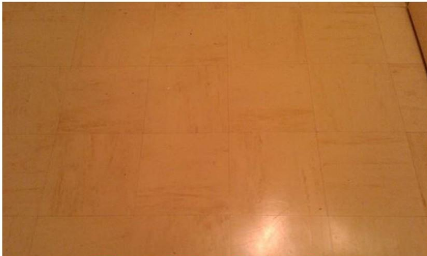
P4 - Dégagement (1er étage - 3) - Sol - Dalles de sol beiges
