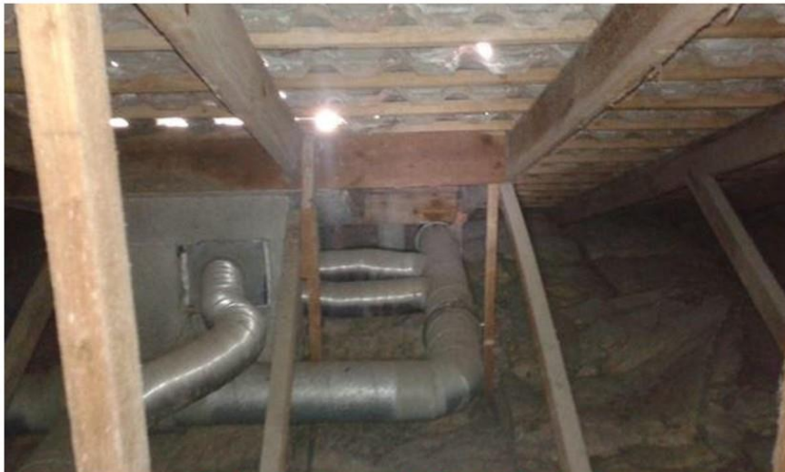
Combles (4ème étage - 1 et 3) - Conduit - Fibre ciment
