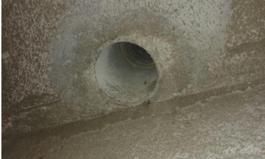
Gaines techniques 2 (3ème étage - 3) - Conduit - Fibre ciment
