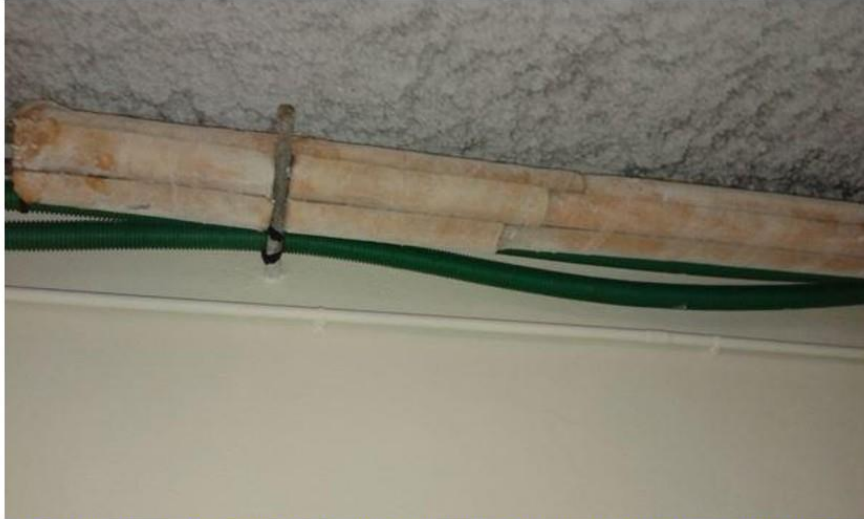
P3 - Local poubelle (Rdc Eraudière I- 3) - Revêtement mur - Calobrifugeage (toile blanche + laine minérale)
