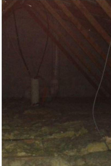
Combles (4ème étage - 1 et 3) - Conduit - Fibre ciment
