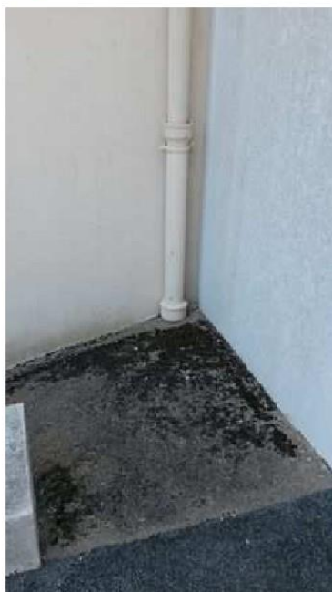
Façades (Extérieur) - Descentes EP - Descentes EP - pieds de colonne
