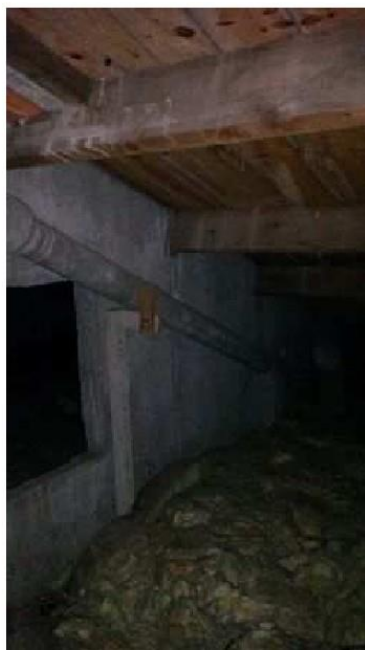
Comble (4ème étage - Entrée A) - Conduits de ventilation, aération - Fibre ciment - (pour exemple)
