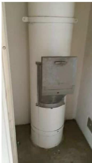
Local vide ordures (1er étage - Entrée A) - Conduit de vide-ordures - Fibre ciment
