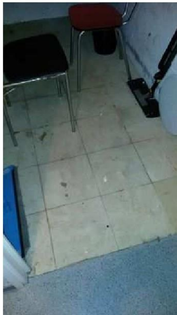
P1 - Local sous escalier (Rdc - Entrée A) - Sol - Dalles de sol (30x30, beige)
