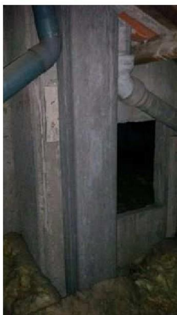
Comble (4ème étage - Entrée A) - Conduits de ventilation, aération - Fibre ciment
