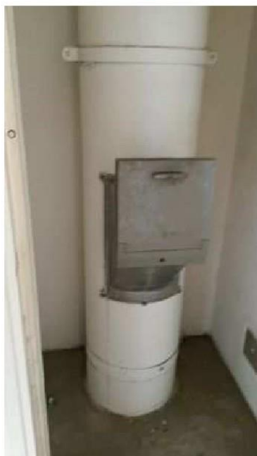
Local vide ordure (1er étage - Entrée A) - Conduit de vide-ordures - Fibre ciment
