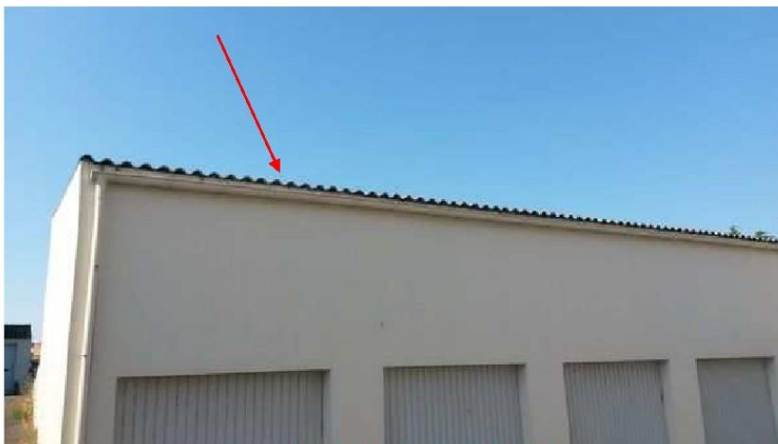
Garages (Extérieur) - Couverture - Fibre ciment
