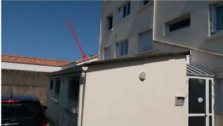
Couverture (caves) (1er étage) - Couverture - Fibre ciment
