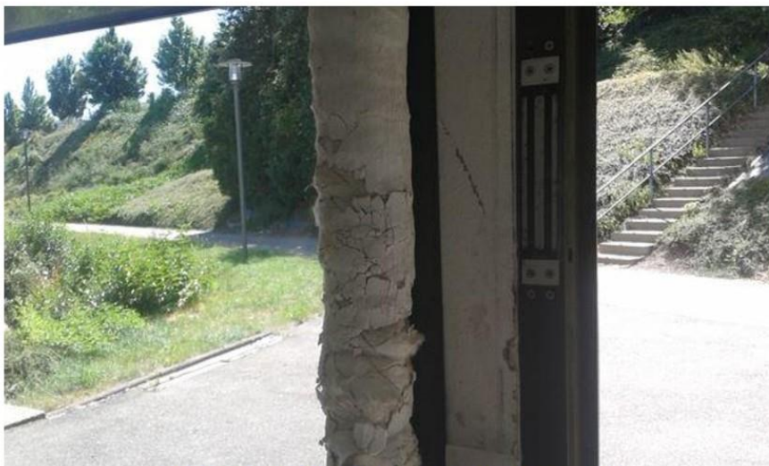
P3 - Local vélo (Rdc) - Revêtement mur - Calorifugeage blanc + plâtre
