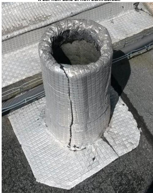
Toiture (5ème étage) - Conduit de ventilation - Fibre ciment
