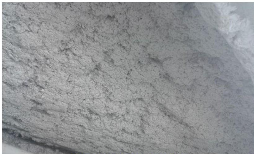
P2 - Local poubelle 1 (Sous sol) - Plafond - Flocage
