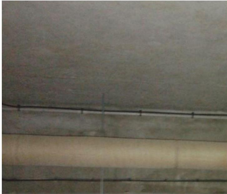
P1 - Local poubelle 1 (Sous sol) - Revêtement mur - calorifugeage toile (marron) + laine de verre
