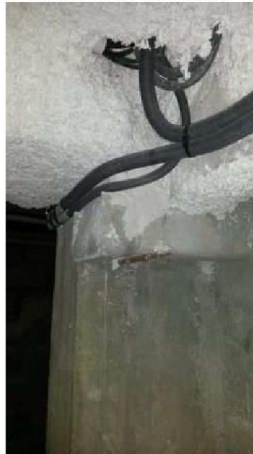
P2 - Circulation cave (Rdc) - Plafond - Flocage
