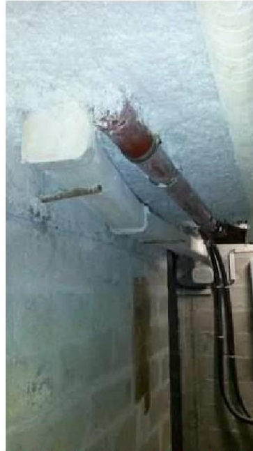
Circulation cave (Rdc) - Conduits de ventilation, aération - Fibre ciment
