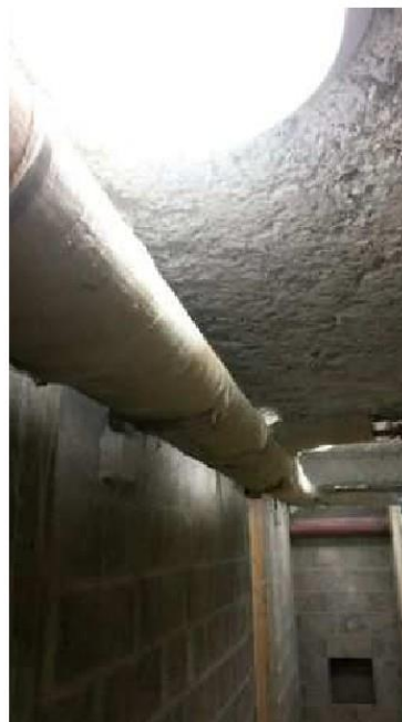
P1 - Circulation cave (Rdc) - Canalisation calorifugée - Canalisation calorifugée
