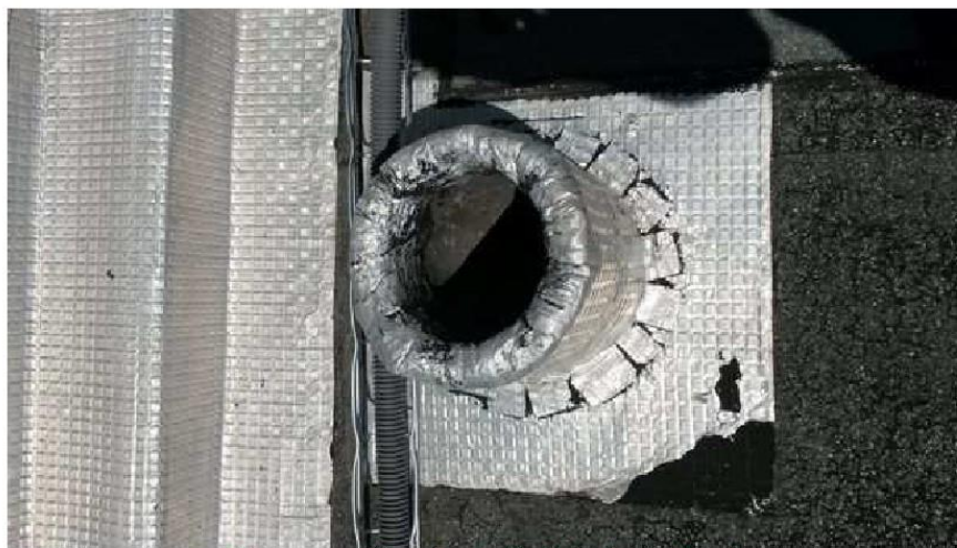
Toiture terrasse (6ème étage) - Ventilation haute - Bouche
